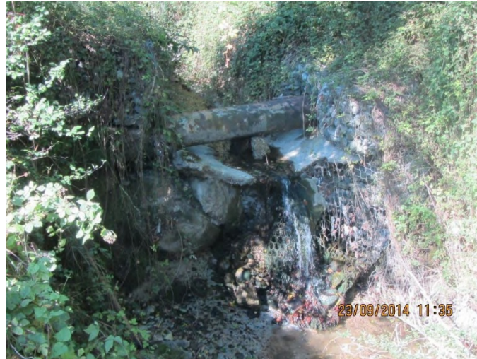
Attraversamento della tubazione smaltimento delle acque urbane, gabbionate danneggiate e salto di fondo
